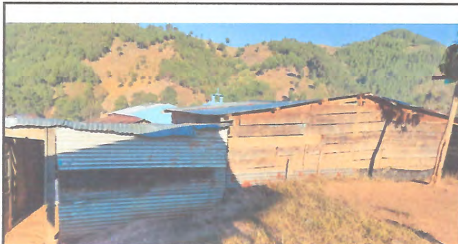
Foto 1: mejoramiento portico con cubierto de lamina
